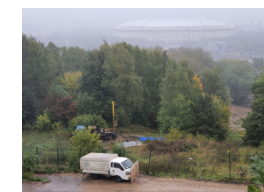
Изучение керна скважины глубиной 80 м на участке изысканий под смотровой площадкой на Воробьевых горах
